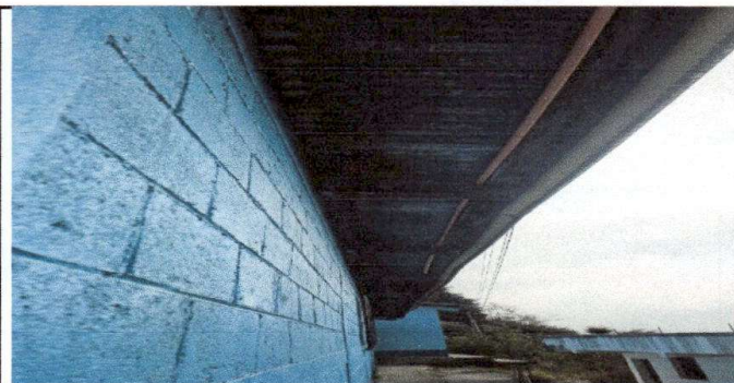
Foto 3: Sustrución de agua pluvial de metal por PVC.
