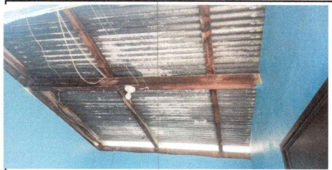
Foto 2: Sustrución de estrucctura de soporte de madera por metal.
